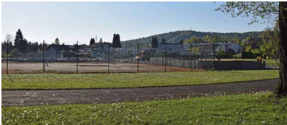
Der Hörbinger Sportplatz wird zu einer modernen, multifunktionalen Sportanlage umgebaut.
